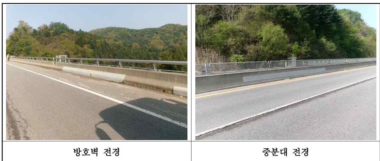
【사진 1.3.23】 방호벽 및 중앙분리대 전경
