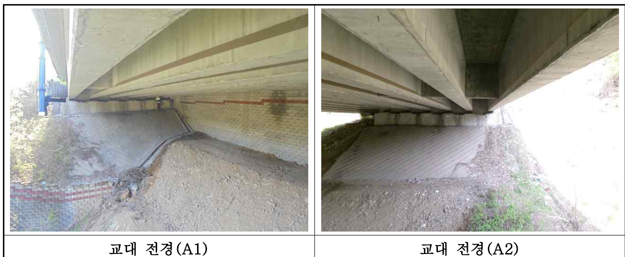
【사진 1.3.8】 교대 전경
