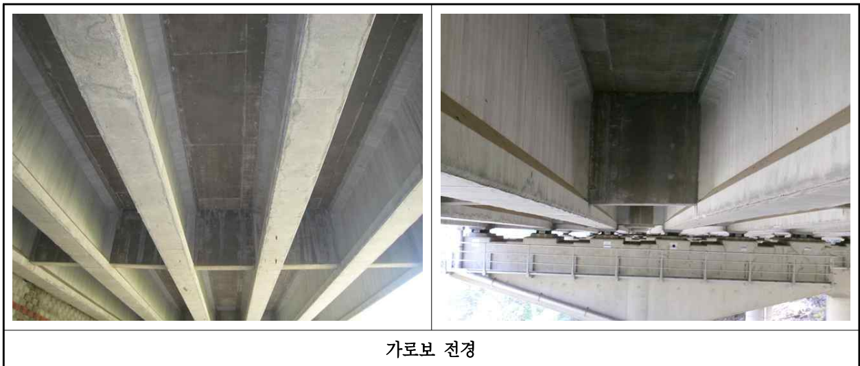
【사진 1.3.6】 가로보 전경
