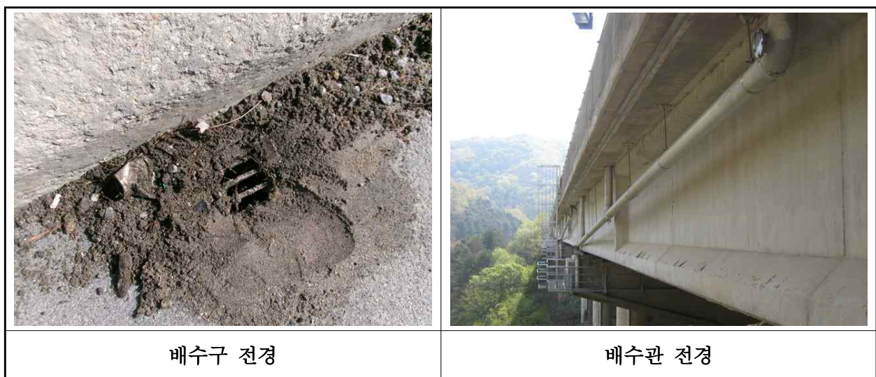
【사진 1.3.21】 배수시설 전경
