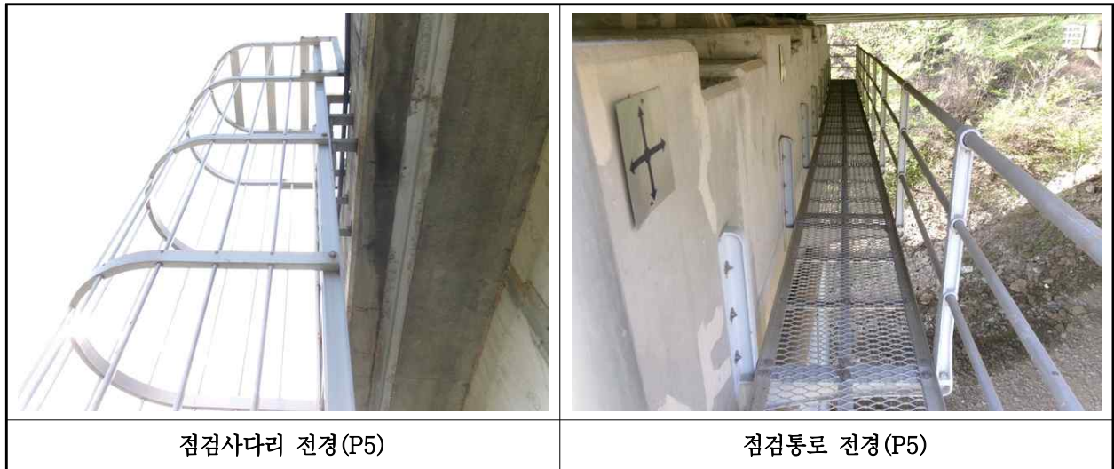
【사진 1.3.25】 교량 점검시설 전경
