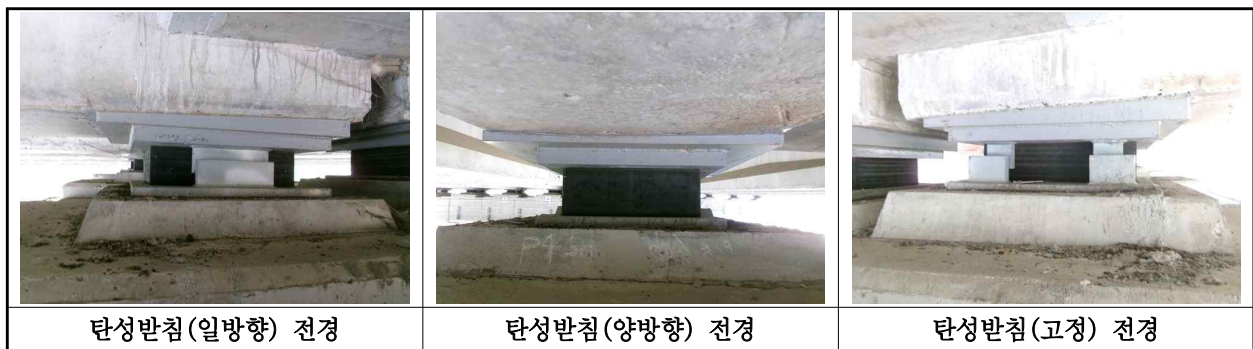
【사진 1.3.12】 교량받침 전경
