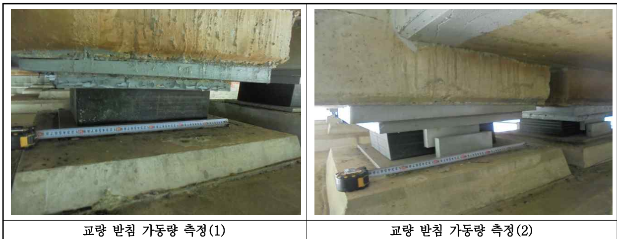
【사진 1.3.15】 교량받침 이동량 측정
