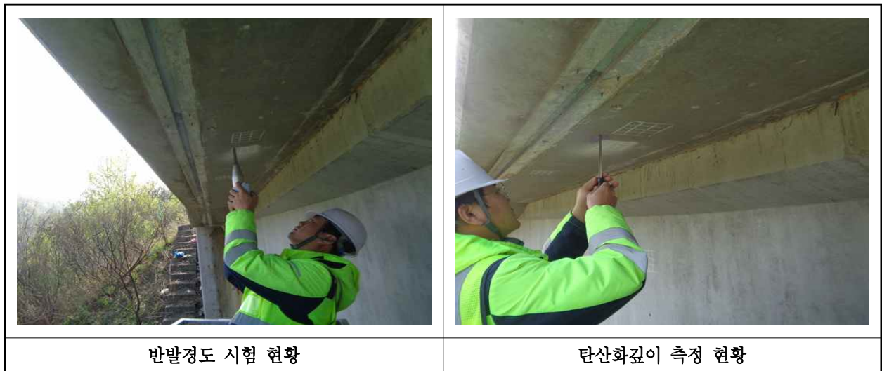
【사진 1.4.1】 콘크리트 내구성조사 현황
